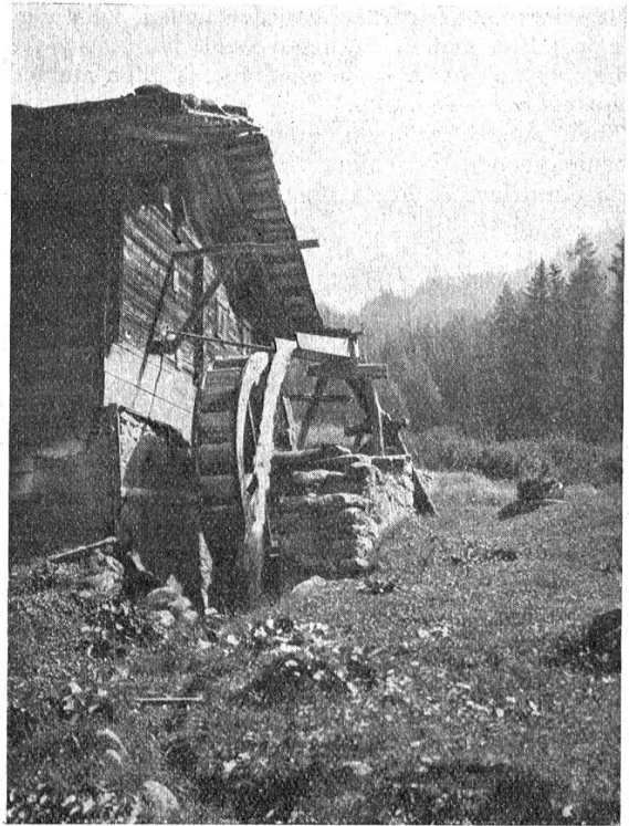
Eine alte, stillgelegte Kundenmühle im Medelstal
