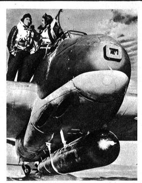
England hat für die Unterseebootabwehr einen neuen Torpedo-Bombertyp geschaffen, den neuen Beaufighter-Bomber. Eine Nahaufnahme des Flugzeugrumpfes mit einem aufgehängten Torpedo. Die Maschine verfügt über einen ausserordentlich grossen Aktionsradius
