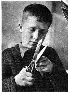
Ausschneiden einer Flügelrippe aus Sperrholz
