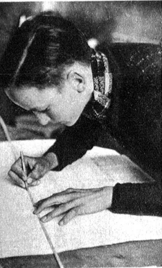
Die Bauteile werden vom Bauplan auf das Sperrholz durchgepaust
