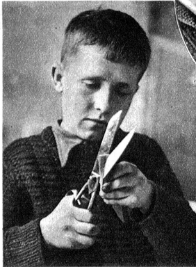
Ausschneiden einer Flügelrippe aus Sperrholz
