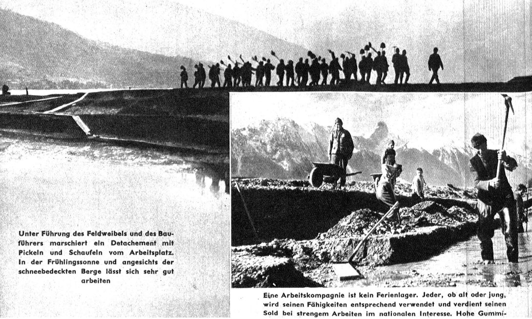
Mit Schubkarren und Rollwagen wird Aushubmaterial zum Auf- schütten eines Damms herangeführt
