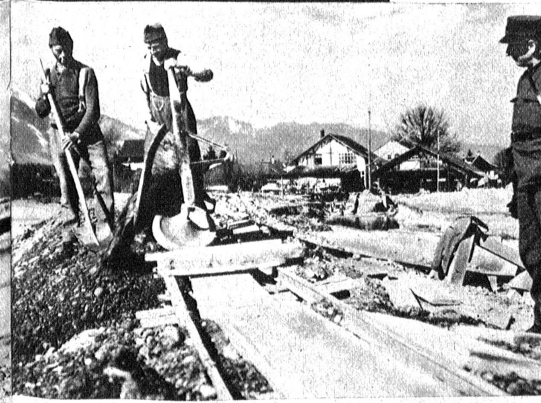
Mit Schubkarren und Rollwagen wird Aushubmaterial zum Auf- schütten eines Damms herangeführt
