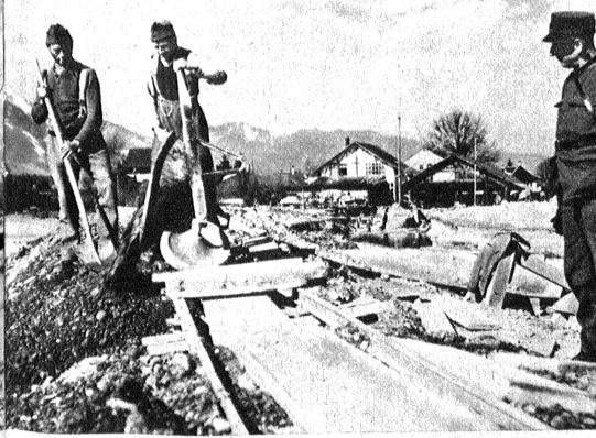
Mit Schubkarren und Rollwagen wird Aushubmaterial zum Auf-schütten eines Dammes herangeführt
