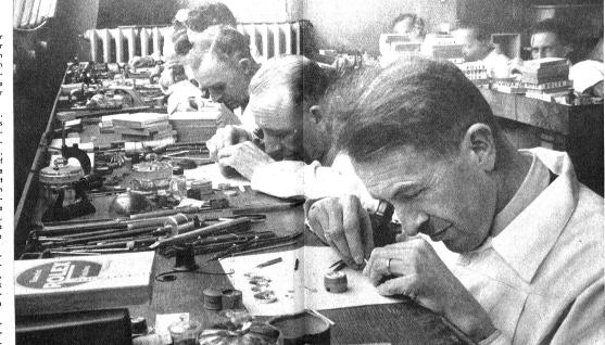
Links: Jedes einzelne Teilchen der kleinen Uhr wird sorafältia repassiert und wieder zusammengestellt
