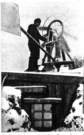
Eine Bunkerbesatzung an der nördlichen Front vor Leningrad hat sich den kalten Ostwind zunutze gemacht, indem sie mit einem Windrad, 2 Veloreifen und 2 Dynamos ein kleines Elektrizitätswerk schuf, das neben Licht auch etwas Wärme spendet
