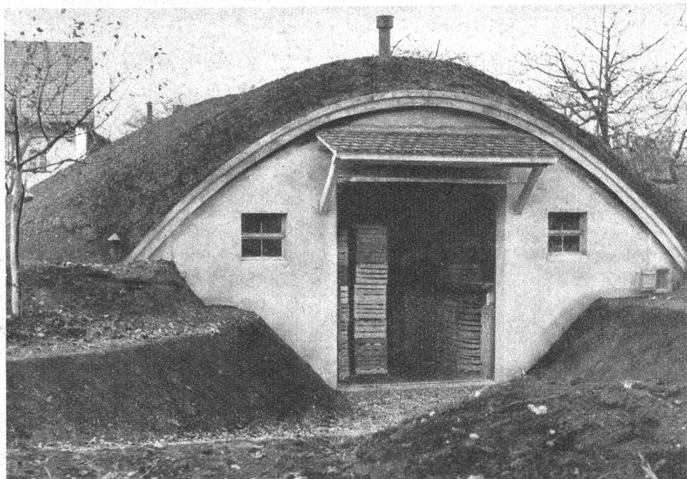
Unten: Der erste „Gemüsebunker“ in der Schweiz. In Kappel bei Olten ist der erste schweizerische „Gemüsebunker“ erstellt worden. Es handelt sich um einen 20 m
