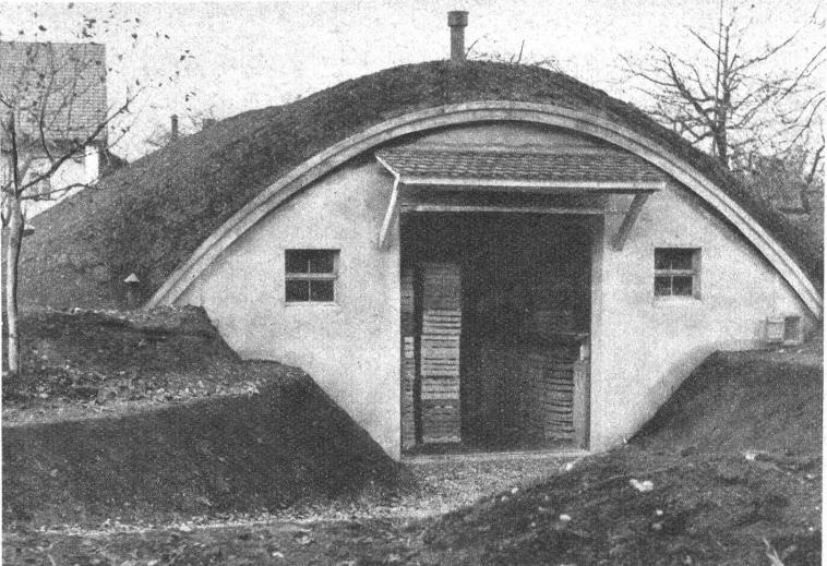
langen, 10 m breiten und 4,5 m hohen Tunnel, der bequem von einem Lastauto durchfahren werden kann. Die Wände sind betoniert, das gewölbte Dach ist aus Backstein und mit einer Beton-, einer Teer- und einer dicken Erdschicht isoliert. Die Durchschnittstemperatur schwankt regelmässig zwischen 2–3 Grad über dem Nullpunkt. Rechts: Blick ins Innere des „Gemüsebunkers“
