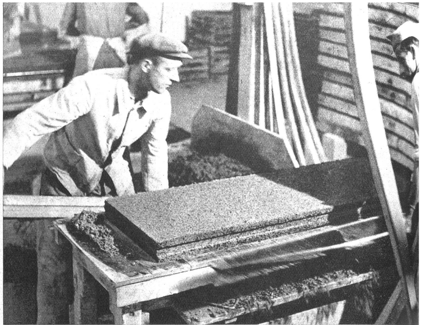
Eine gerade geformte, noch nasse Bauplatte wird aus dem Rahmen herausgenommen
