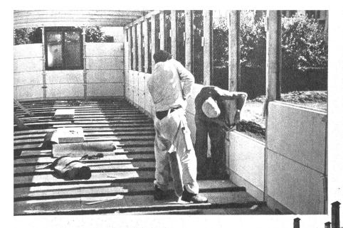
Links: In der modernen Bauweise kann mit Durisol-Platten ein Resultat erzielt werden, das allen Anforderungen des heutigen Lebens entspricht. Einfach und rasch werden die Platten in den Ständerbau eingesetzt.
