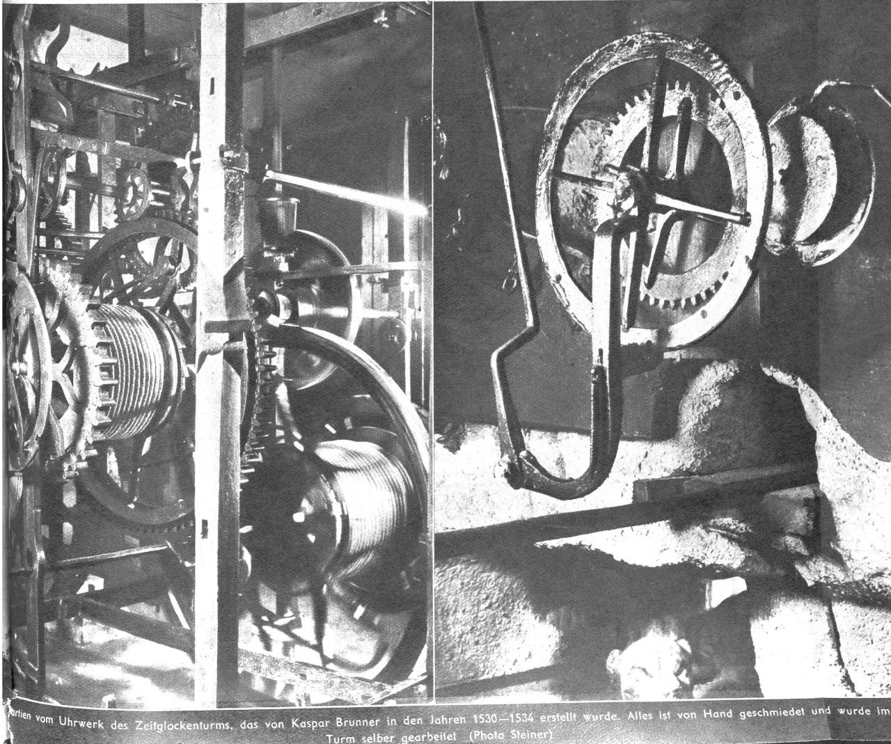
Detailansichten vom Uhrwerk des Zeitglockenturms, das von Kaspar Brunner in den Jahren 1530—1534 erstellt wurde. Alles ist von Hand geschmiedet und wurde im Turm selber gearbeitet (Photo Steiner)
