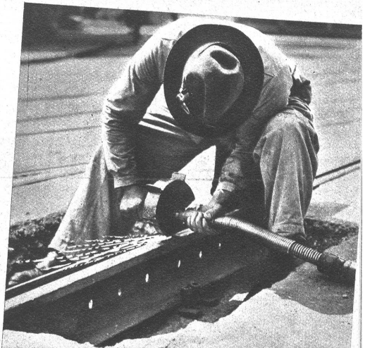
Die rauen Stellen werden mit Hilfe einer elektrisch betriebenen Schmirgelscheibe geschliffen
