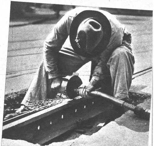
Die rauen Stellen werden mittelst einer elektrisch betriebenen Schmirgelscheibe geschliffen
