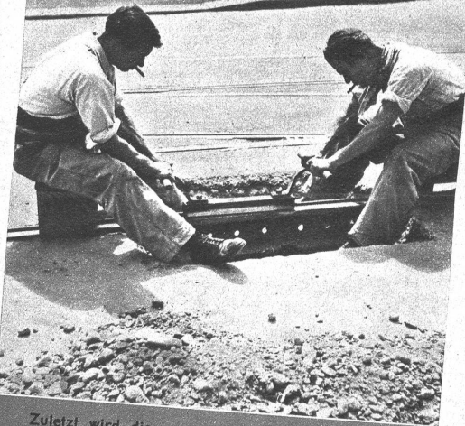
Zuletzt wird die ganze Schweißstelle, soweit sie befahren wird, mit dem Schienenhobel abgeglättet
