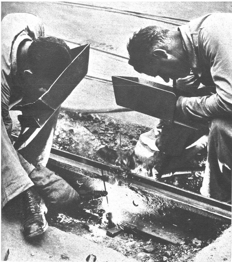
Vorerst wird eine Flusseisenplatte unterlegt und verschweisst, sodann die Lücke im Schienenkopf und im Steg mit Schweissgut ausgefüllt
