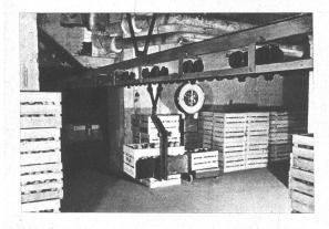
Links: Einlagerung. Zufuhr durch Transportkette
