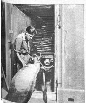
eholztrocknung und Prüfung auf den Behalt mit Hitfe des elektrischen
