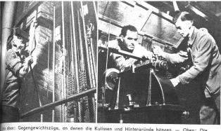
s oben: Gegengewichtszüge, an denen die Kulissen und Hintergründe hängen. — Oben: Die kmachinerie sorgt für den Aufzug der Kulissen und Dekorationen auf die Bühne. — Rechts n: Machinerie für den versenkbaren Teil der Bühne, sogenannte Kassettenversenkung : Leseprobe mit Doswald als Regisseur, Lohner und dem Inspizienten Bernhard
