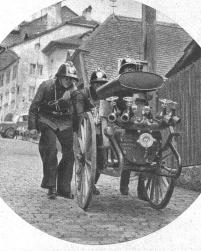
Wo der Hydrantendruck nicht genügt, muss die Motorspritze in Stellung gebracht werden, sei es das Pumpenaggregat der Motorspritze seibst oder das Pumpenaggregat einer kleinen abprotzbaren und leicht transportablen Kleinmotorspritze. Diese Klein-Motorspritze wird abgepackt und zum Wasserbezugsort gefahren
