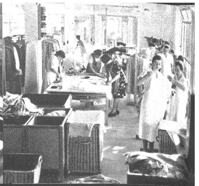
Grosse Wäschestücke werden sorgfältig geprüft und behandelt
