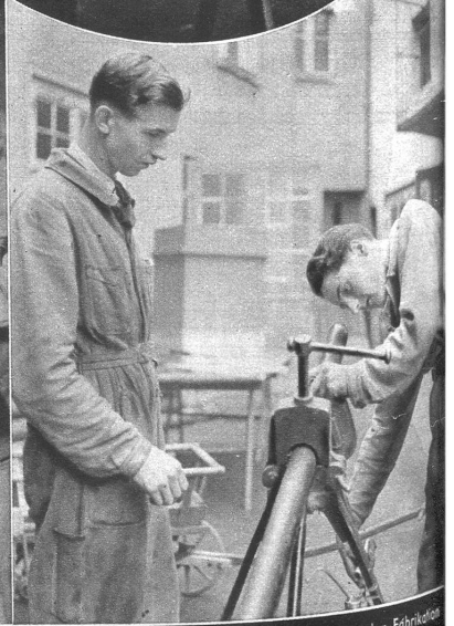
Beim Rohrschneiden. Wie bei jeder Fabrikation müssen auch in diesem Betriebe Arbeiten allgemeiner Natur ausgeführt werden
