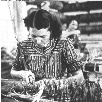
Hier laufen die Drähte zusammen und werden zu einem festen Kabel verbunden, wie sie in der Telephonie Verwendung finden
