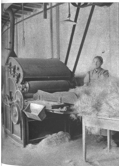
In dieser langen Maschine wird das Pferdehaar bereitet, bevor es in die Spinnerei kommt
