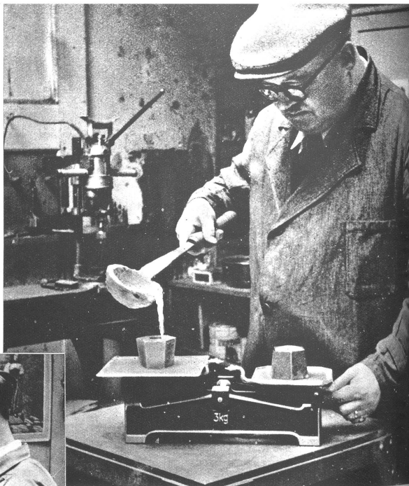
Die Berner Eichstätte. Marktfrauen bringen regelmässig nach Marktschluss ihre Waagen zur Eichstätte zur Kontrolle und Einlagerung bis zum nächsten Markttag. Rechts: Ein neuer Gewichts-„Stein“ wird bis zum annähernden Soll-Gewicht mit Blei ausgegossen. Die genaue Ausregulierung erfolgt auf der Prüfwaage.
