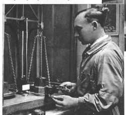
Auf der Prüfwaage. Mit der Pinzette werden bis zum exakten Gewicht Schrotkörner zugegeben, dieselben sodann der Kernmasse beigestampft, worauf die Stempelung erfolgt
