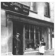
Die Berner Eichstätte. Marktfrauen bringen regelmässig nach Marktschluss ihre Waagen zur Eichstätte zur Kontrolle und Einlagerung bis zum nächsten Markttag Rechts: Ein neuer Gewichts-"Stein" wird bis zum annähernden Soll-Gewicht mit Biel ausgegossen. Die genaue Ausregulierung erfolgt auf der Prüfwaage
