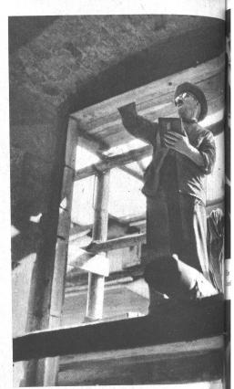
Hier wird verputzt. Jede Fuge des einst so baufiligt wird behandelt, der Bau soll sich später nicht mehr von abheben
