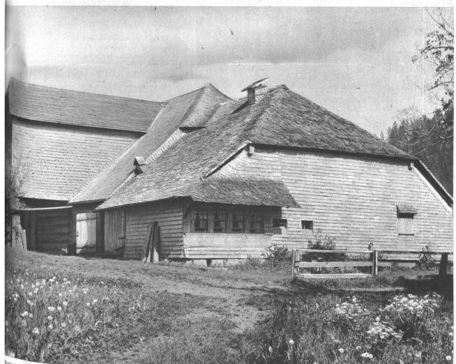
Volenhaus, hinter dem Schwendelberg: Die Wetterseite ist vom First bis zum Sockel mit Schindeln "gepanzert" zum Schutz gegen den Westwind, den Regen und die Schneestürme
