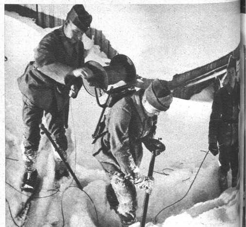
Kein Vergnügen, Leitungsbau im metertiefen Schnee! Das Kilo am Rücken wiegt mit der vollen Rolle an die 30 kg
