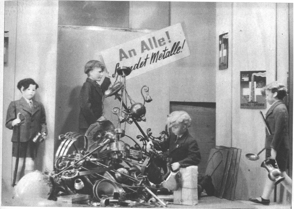
Schaufenster der Firma KZ Burgerlehl & Co. AG, Lahnholzplatz 1
