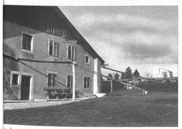
La Ferrière. Das Regenwasser wird durch Dachkänel in die grossen Zisternen geleitet und mit der Handpumpe von der Küche aus in den Schüttstein befördert. Eine Leitung führt direkt in den Stall
