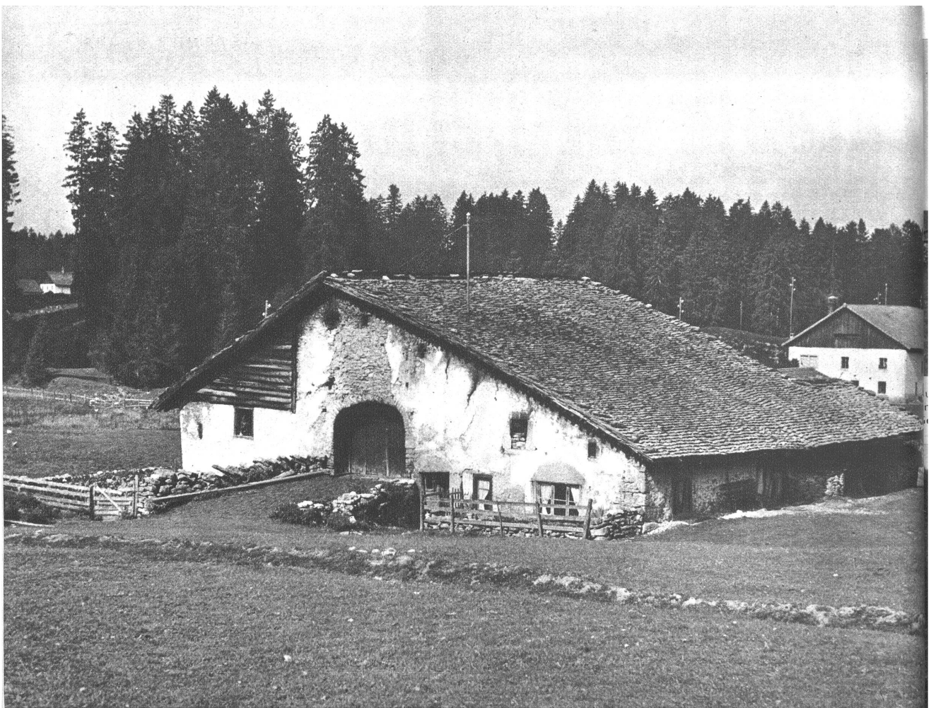
Ein Urhaus in Prédames in den Freibergen: Sein Dach besteht noch aus den groben Bretterschindeln, seine Wohnung liegt als Nebensache tief unter dem schattigen Tor, sein gewölbtes Tor ist noch gut erhalten
