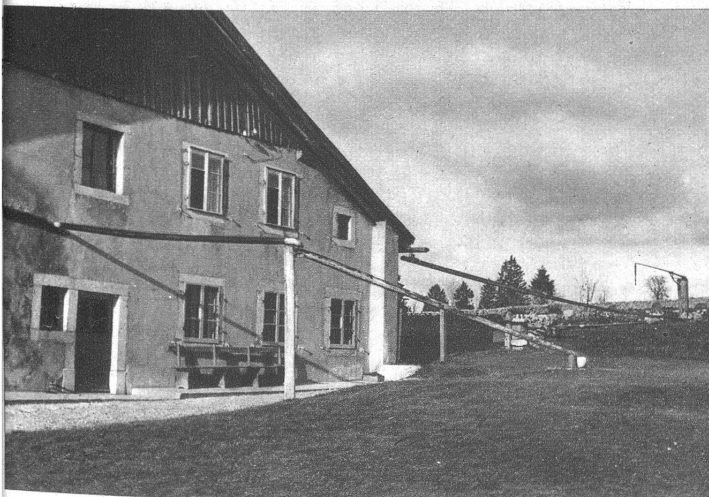
La Ferrière. Das Regenwasser wird durch Dachkaneln in die grossen Zisternen geleitet und mit der Handpumpe von der Küche aus in den Schüttstein befördert. Eine Leitung führt direkt in den Stall
