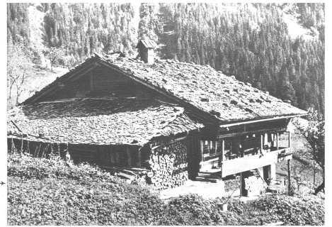
→ Das steinbeschwerte Satteldach eines Habkern-Hauses in seiner malerischen Schönheit. Selbst die beiden Kamine tragen hölzerne Dächlein
