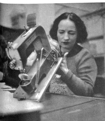
Jede Schraube muss nachkontrolliert und wenn nötig nachgezogen werden.
