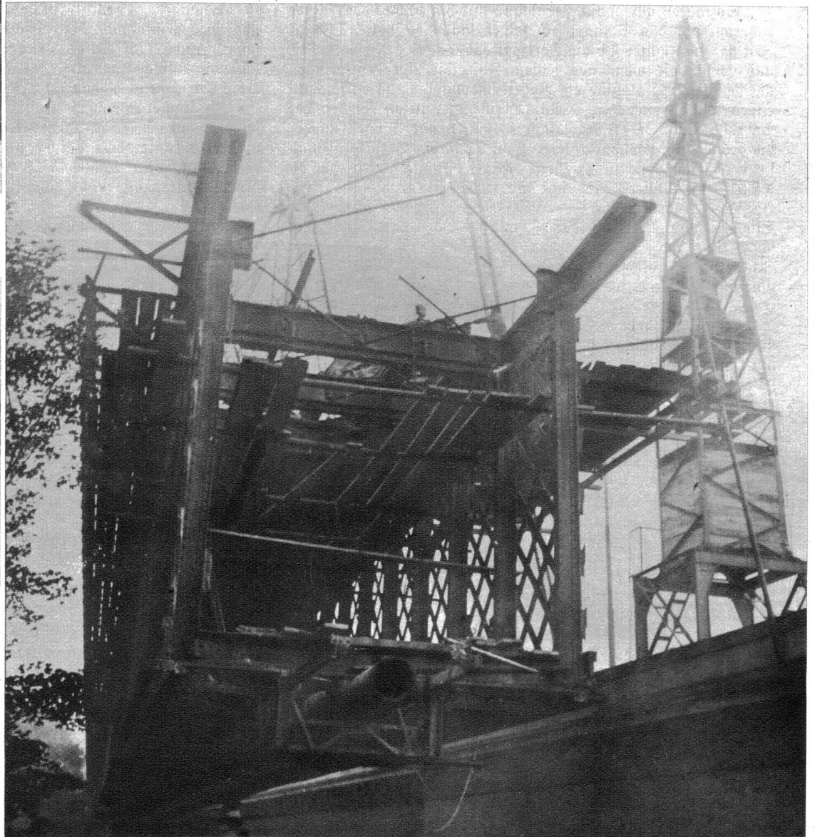
Die alten schweren Eisenträger werden mit Winden und Kranen abmontiert. Im Hintergrund das Symbol der neuen Ära.
