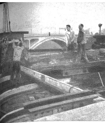
Die alten schweren Eisenträger werden mit Winden und Kranen abmontiert. Im Hintergrund das Symbol der neuen Ära.
