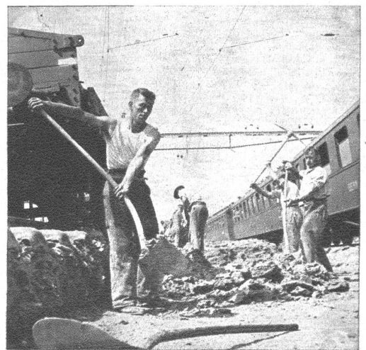
Während den Umleitungsarbeiten wurde die Verkehrsfrequenz ohne Unterbruch aufrecht erhalten.
