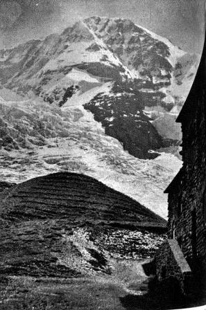
In der Nähe der Station Eigergletscher, auf einer Felsrippe, is das Reservoir errichtet. Zuerst wurde der Platz aus dem Felsgesprengt, dann das Reservoir mit zwei runden Kammern niert und zuletzt mit einem Erdhügel überdeckt. Im Hintergrund der Mönch grund der Mönch.
