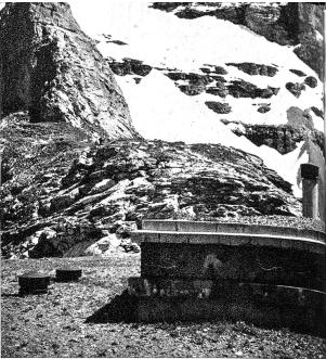
Die Ventilationskamine des Reservoirs. Rotstock und Eiger. Ungefähr in der Gegend, wo der unterste Schneekegel in in scharfe Spitze nach oben ausläuft, befindet sich die Wasserfassund.h. das Felsbassin und weiter unten das Filterfass.
