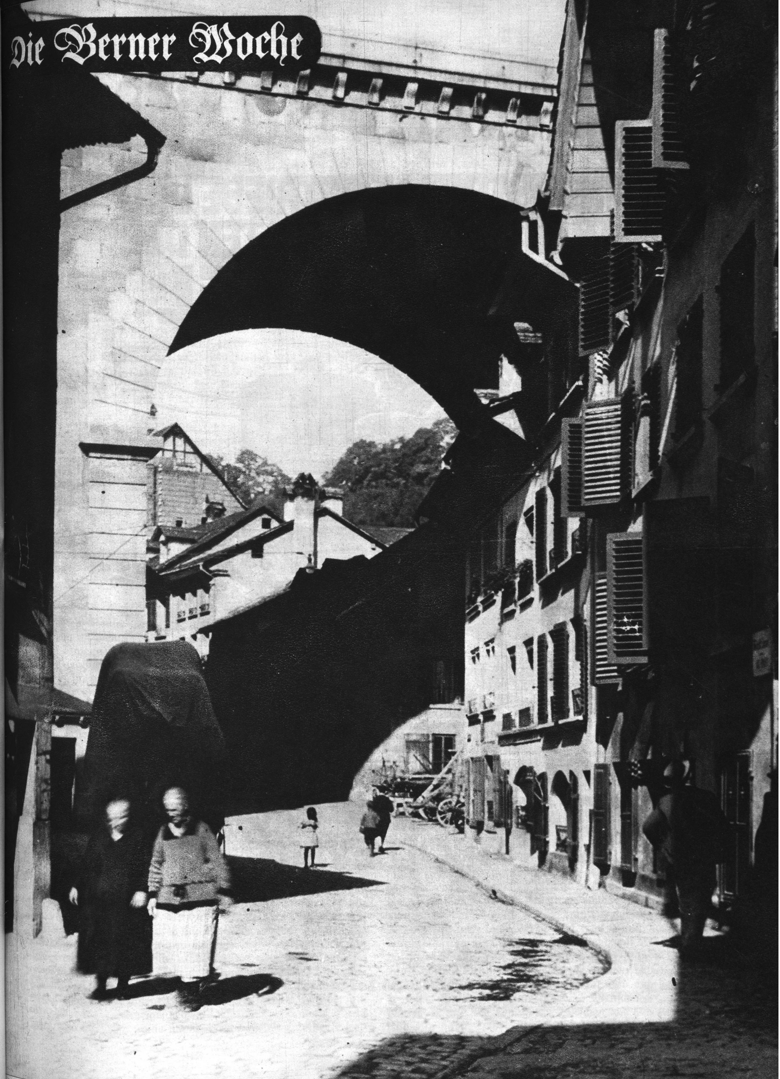
Die Nydeckbrücke steht seit der Grundsteinlegung nun schon 100 Jahre in Bern und manches Schicksal erfüllte sich im Schatten ihrer Grösse.
