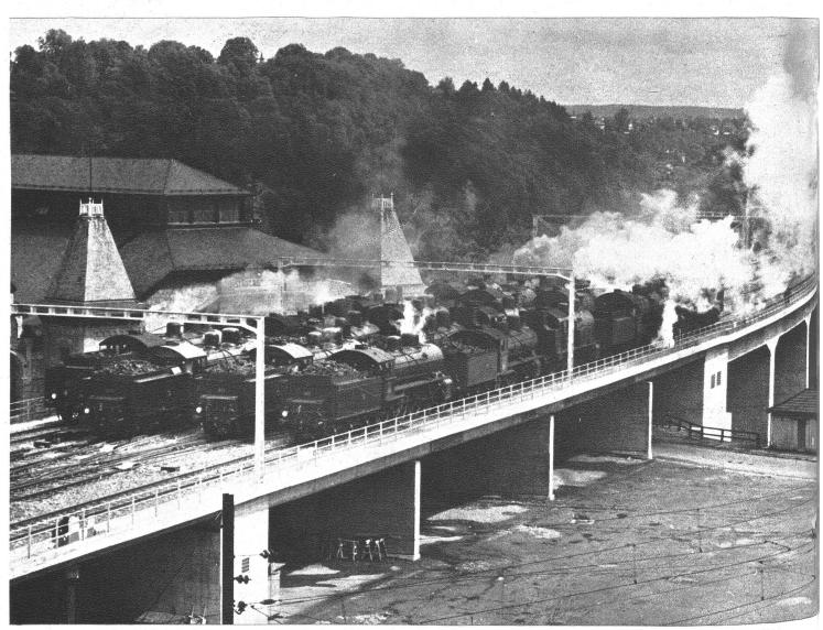
Das Verhalten der Brücke bei der Belastungsprobe wurde an acht verschiedenen Punkten mit grösster Sorgfalt und mit besten Instrumenten gemessen. Auch die Spannung im Brückeninnern wurde mit Präzisionsprüfern vorgenommen. Der die Vermessungsarbeiten leitende Ingenieur teilte mit, dass die praktisch gewonnenen Resultate den Vorberechnungen entsprechen.
