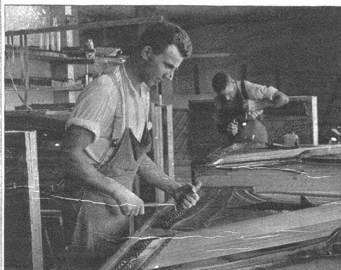
Einbau der Saiten.
