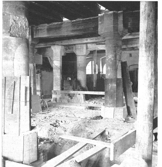
Die gegenwärtigen Umbauarbeiten haben eine große Überraschung besichert, nämlich die Entdeckung einer grossen Säulenhalle zu ebener Erde, die durch Ein- u. Umbauten bisher vollkommen unkenntlich war und von der man auch keine anderweitige Kenntnis mehr hatte. Diese fast kirchenähnliche Säulenhalle mag ursprünglich als Gerichtshalle gedient haben oder möglicherweise auch als Versammlungsort der Bürgerschaft benutzt worden sein.
