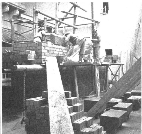
Sandsteinquadern werden gesetzt. Sandstein ist das traditionelle Baumaterial der Stadt, das ihr den einheitlichen baulichen Aspekt verschafft. Es ist Vorschrift, dass die Fassaden im Gebiet der Altstadt alle aus Sandstein bestehen müssen.
