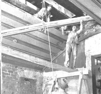
Sorgfältig werden die mit Wappen geschmückten Balken der gewölbten Holzdecke des alten Regierungsratsaales gelöst und abgenommen.
