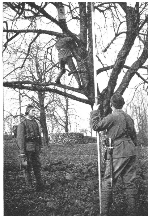
Unterwegs auf dem Linienbau. Dieses Bild veranschaulicht einen kleinen Ausschnitt der Tätigkeit wie sie öfters vorkommt. Der Mann auf dem Baum macht sich daran, den Draht zu oberst im Geäst mit einem sogenannten „Mastwurf“ zu befestigen. Nur wenn die Linie hoch genug hängt, braucht man bei längeren Spannungen nicht zu befürchten, dass der Draht im Manövergelände von den Truppen zerrissen wird.
