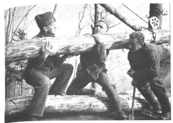
Auf der Holzbühne werden die Trämel mit mehr oder weniger lauten Kommandos gehoben und vermittelst Ketten und Klammem am Seilzug befestigt.
