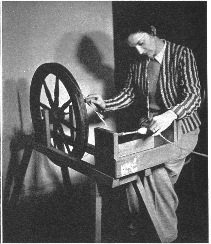
Am Spulrad beim Aufspulen des Garns.
