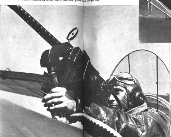
Das Auge des Beobachters: Die Kamera. Mit diesem Gerät, das für die Senkrechtaufnahmen im Innern des Beobachterplatzes, für Schrägaufnahmen über Bord gehandhabt wird, enteisst der Fliegerbeobachter dem Feind manch wichtiges Versteck. Diese Kamera ermöglicht es, feindliche Stellungen, Brücken, Munitionslager usw. genau festzustellen. Die Fliegerphotos sind die Wegweiser für Angriffe der Bomberstaftel im Hoch-, Tief- oder Sturzflug.
