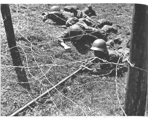
Die gestreckte Ladung, ein 7 m langes mit Sprengstoff gefülltes Eisenrohr, wird unter das Drahlhindernis geschoben. Zensur Nr. N/V. 1882, 1895.
