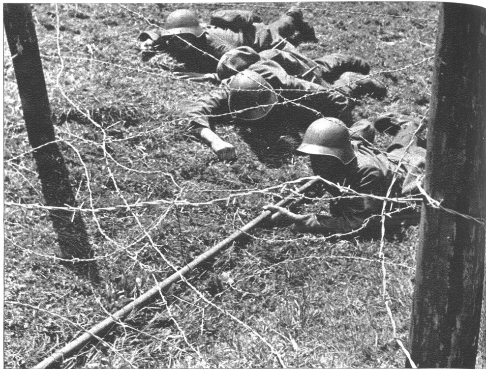
Die gestreckte Ladung, ein 7 m langes mit Sprengstoff gefülltes Eisenrohr, wird unter das Drahthindernis geschoben. Zensur Nr. N/V. 1882, 1895.
