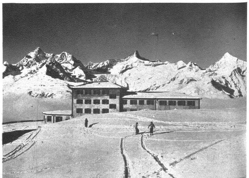
Ein idealer Ausgangspunkt für hochalpine Skitouren: Das umgebaute und neueröffnete Hotel Riffelberg ob Zermatt, 2585 m ü. M. In diesem Winter fährt die Gornergratbahn erstmals durch die am lawinengefährlichen Steilhang ob Riffelboden erstellten 770 m lange Schutzgalerie bis auf Riffelberg, wo der Skifahrer auch ein prächtiges, von den Walliser Viertausendern umstandenes Übungsgelände findet und in dem ebenso heimeligen wie komfortablen neuen Berghaus gut aufgehoben ist. (Phot. Perren)
