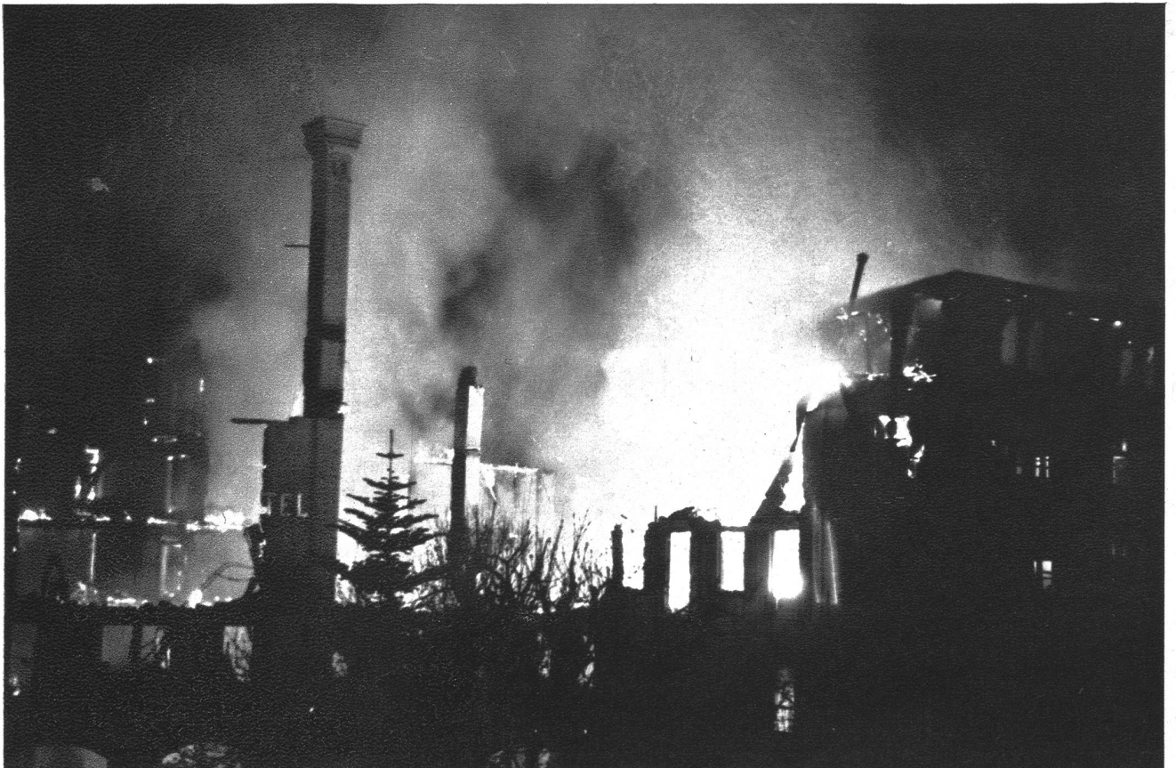
Das Hotel Baer während des Brandes.
