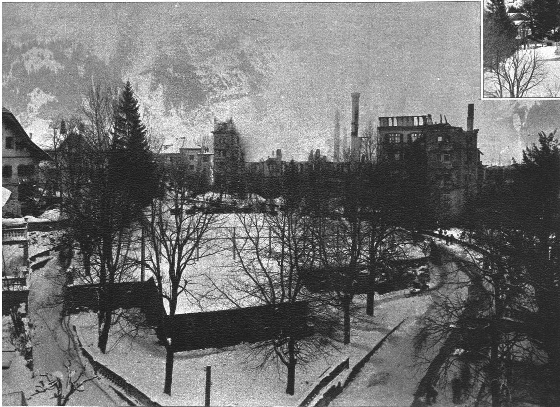
Die ausgebrannte Ruine dieses einst so berühmten Hotels.
