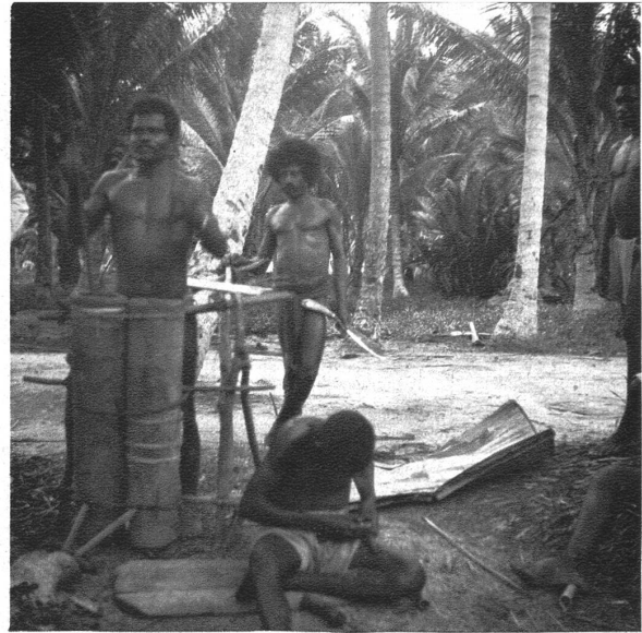
Eingeborner Schmied, mit Blasbalg aus Bambusrohr.
