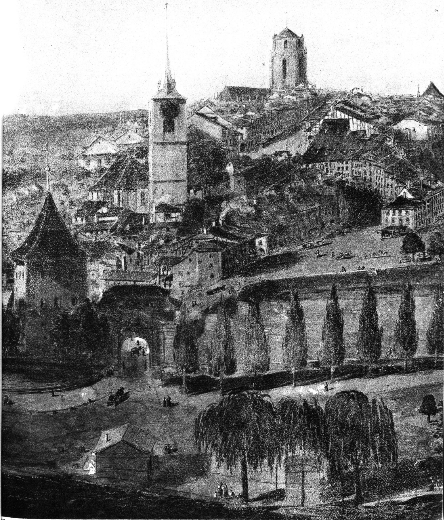
Die Unterthorbrücke im Wandel der Jahrhunderte. Stadteingang beim Unteren Tor (Aquarell von Architekt von Graffenried im Historischen Museum Bern).
