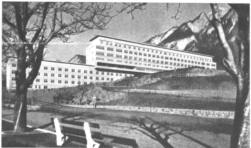
Klimaanlagen für sämtliche Behandlungsräume im Rhätischen Kantonsspital in Chur
