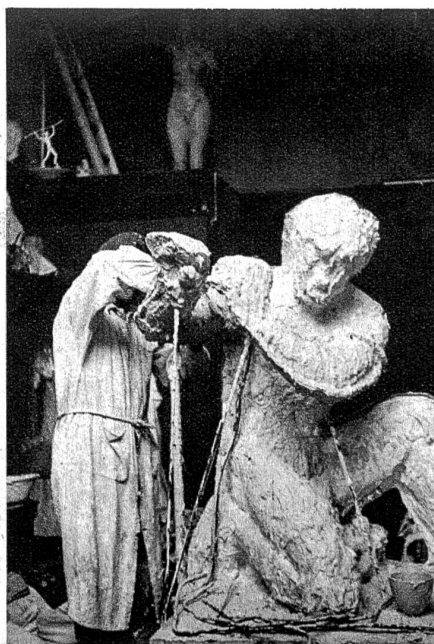
Zur Festigung des Gipsnegatives werden, außer einer weiteren Schicht, Eisenstäbe beigegeben, die der Oberfläche des Lehmpositives parallel laufen und somit die Form beschützen gegen die Wirkungen des Dehnvermögens beim festwerdenden Gips, natürlich auch gegen ev. Brüche.
