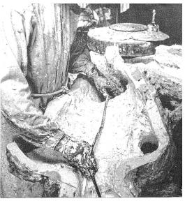
Stück um Stück des Negatives wird nun mit Gips, der wiederum mit Eisenstäben und auch Sacktuch (Emballage) gestärkt ist, ausgegossen, d. h. der Gips wird jetzt auf ein Gipsnegativ aufgetragen.
