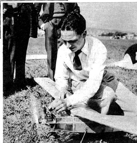
Dieser Einzwölfstel-PS-Motor hat die Aufgabe, das Flugzeug vom Boden auf in die Höhe zu führen. Nach einer gewissen Zeit setzt die motorisierte Antriebskraft aus — und das Flugmodell bleibt dem freien Spiel der Windströmungen überlassen.
