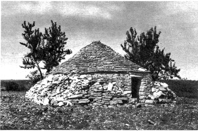
Der primitive Stallbau, der aus Feldsteinen erbaut wird.
