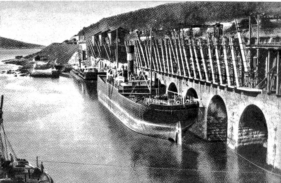
Erzverladungsbrücke in Narvik. In Narvik wird das nordschwedische Eisenerz verladen, weil die Wasserstrasse des Bottnischen Meerbusens bis in das Frühjahr hinein durch Eis blockiert ist. Die Eisenerze werden durch die elektrisch betriebene Eisenbahn aus den Gruben Kiruna und Luossavaara, wo sie im Tagbau abgebaut werden, herangebracht. Die Erzzüge fahren auf die hohe Brücke und das Erz wird durch die (im Bilde hochgeklappten) Rinnen unmittelbar in die Transportdampfer geschüttet. Narvik zählte 1930 nicht mehr als 8475 Einwohner. Seine Bedeutung und gegenwärtige „Berühmtheit“ verdankt es einzig seiner Erzverschiffung. Der jährliche Export betrug vor dem Kriege über 6 Millionen Tonnen Erz. Daneben darf auch der Fischfang erwähnt werden, der für Narvik ebenfalls eine gewisse Rolle spielt. Westlich Narvik sind es nur wenige Kilometer bis zur schwedischen Grenze. Schon deshalb ist die strategische Bedeutung von Narvik ohne weiteres klar, ganz abgesehen vom Eisenerz. Wer Narvik besitzt, besitzt oder kontrolliert einen Teil der so überaus wichtigen schwedischen Waffenlieferungen.
