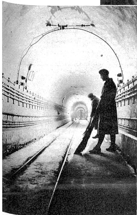
Grosser Verbindungsstollen in der Maginot-Linie. Die einzelnen Festungswerke sind durch solche bombensichere Verbindungsgänge tief unter der Erde miteinander in Zusammenhang. Durch diese Stollen können auf schnellstem Wege mittels elektrischer Bahnen Mannschafts-, Munitions- und Materialtransporte vorgenommen werden. (Photo Keystone)
