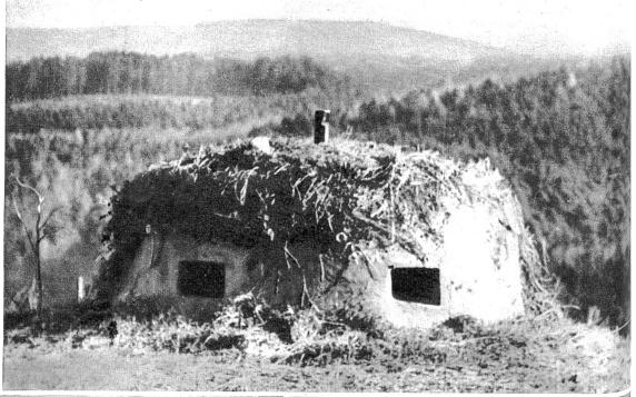
Getarnter Bunker im Westwall. Er ist so getarnt, dass er für den Gegner aus der Ferne kaum sichtbar ist. Sein Schussfeld beherrscht einen genau abgegrenzten Teil der Frontlinie. (Associated Press).
