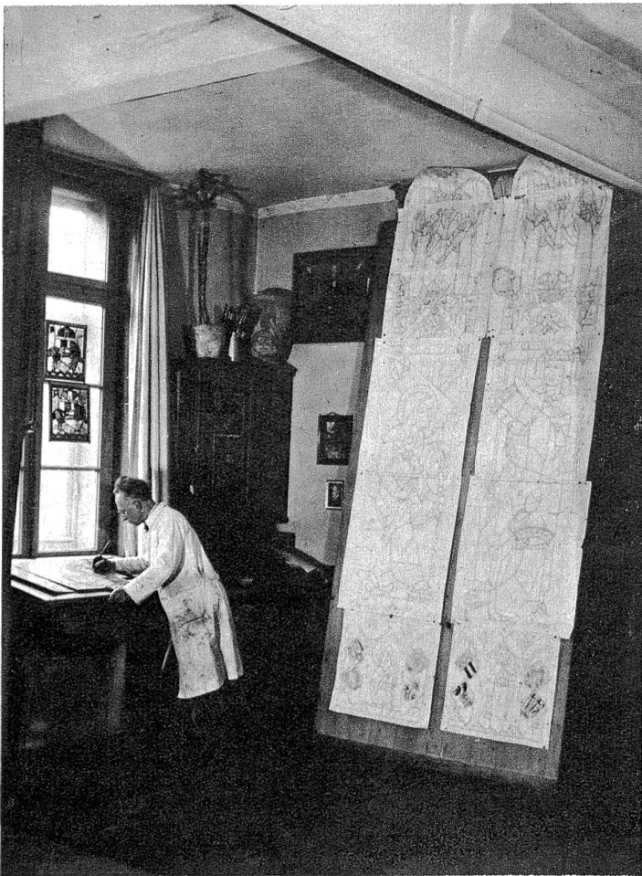
Der Entwurf zum Glasgemälde wird auf Cartons aufgezeichnet. Nach diesen Cartons werden Schablonen geschnitten, die als Vorlagen für die Gläser dienen.
