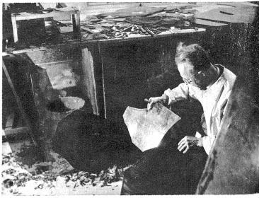
Etwas vom Wichtigsten ist die Auswahl des Glases. Es muss in Farbe und Glanz der Vorlage entsprechen und sich harmonisch in das Gesamtbild einfügen. Besonders bemerkenswert ist, dass die Farben bei durchstrahlendem Licht andere Werte aufweisen, wie in auffallendem. Einzelne Farben lassen mehr Licht durch als andere, sie "überstrahlen". Dies muss bei der Komposition der Gemälde berücksichtigt werden.
