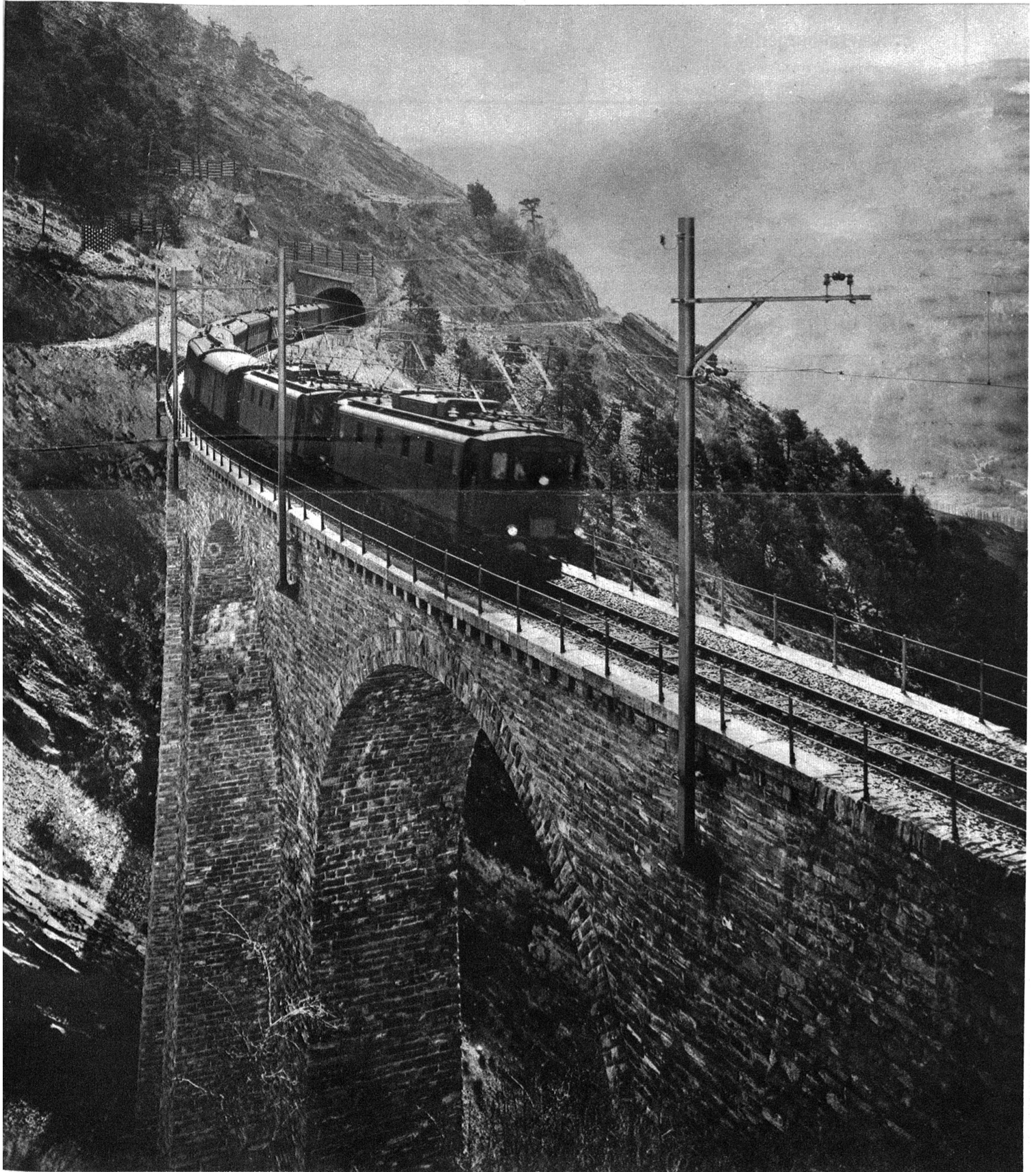
Die Schweiz als Brückenland. Luegelkinnviadukt an der Lötschbergbahn.
