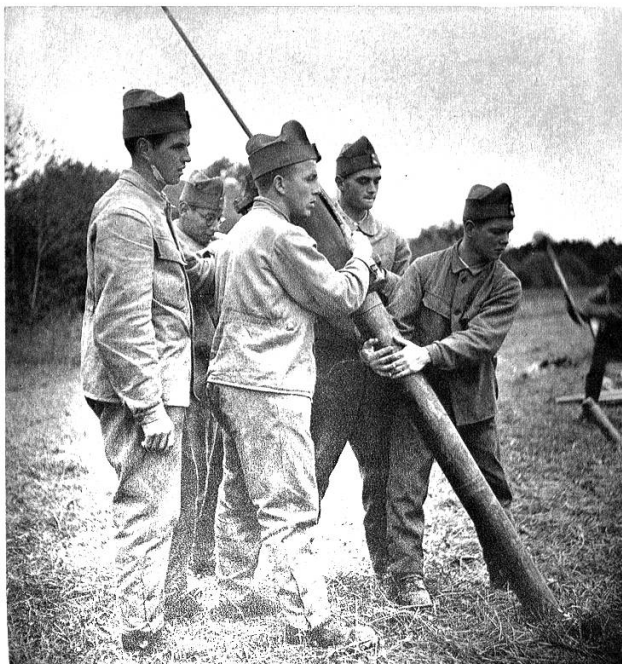
Eine Gruppe rammt Pfähle für eine Landverankerung für die soeben fertig erstellte Brücke.
