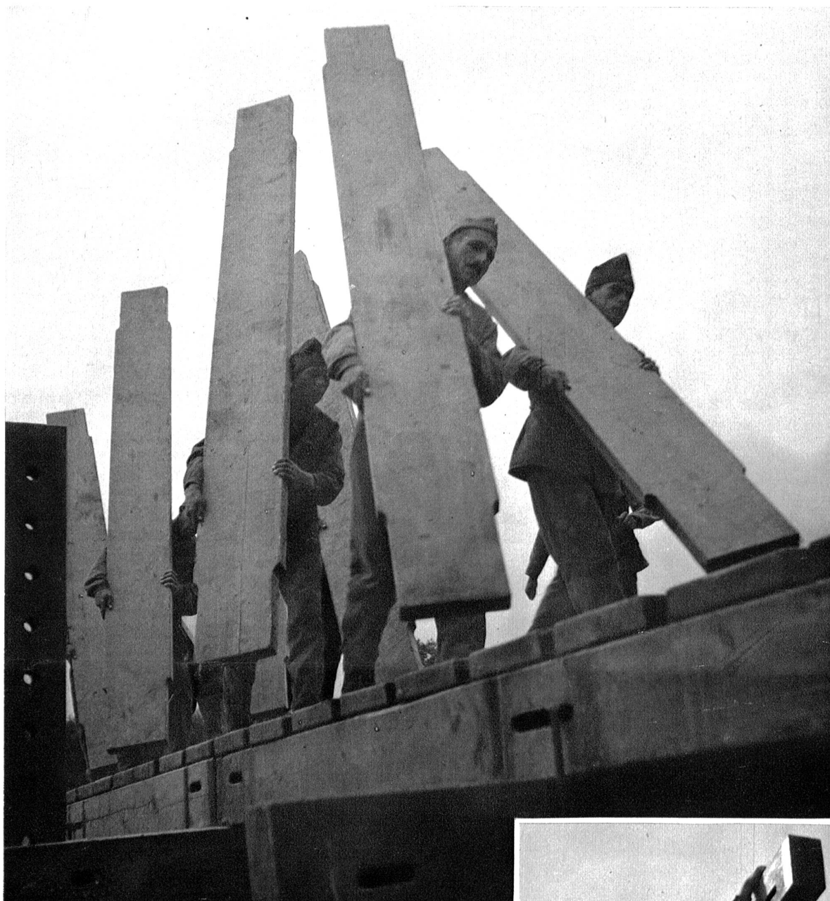
Ein Ladetrupp schreitet mit 20 Läden, die für eine Brückenspannung von 7 m Länge benötigt werden, über den bereits fertig erstellten Teil der Pontonbrücke hinweg.
