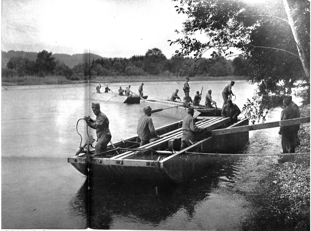
Die Brücke ist ausgebaut, die Anker sind gelichtet worden und es werden jetzt die Schiffe ans Ufer gefahren, um abgerüstet zu werden.
